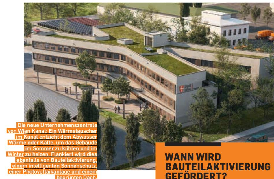
Die neue Unternehmenszentrale von Wien Kanal: Ein Wärmetauscher im Kanal entzieht dem Abwasser Wärme oder Kälte, um das Gebäude im Sommer zu kühlen und im Winter zu heizen. Flankiert wird dies ebenfalls von Bauteilaktivierung, einem intelligenten Sonnenschutz, einer Photovoltaikanlage und einem begrünten Dach.
