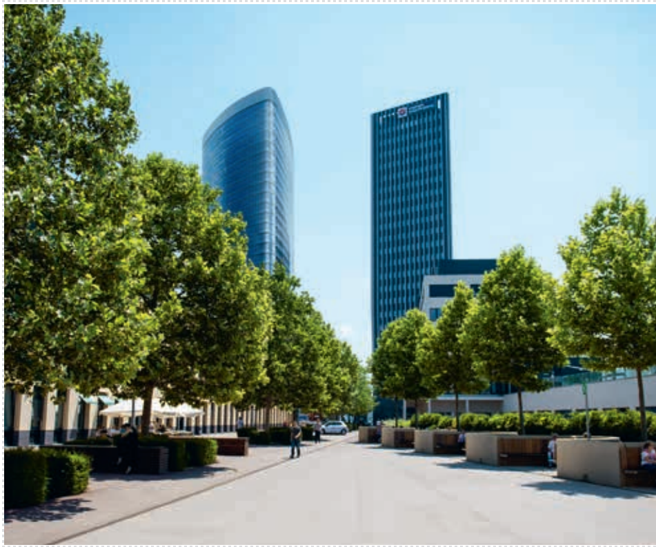
Der Orbi Tower in TownTown wird 2017 fertig gestellt. Dann wird es plötzlich wieder viele Büroflächen am Wiener Markt geben.
